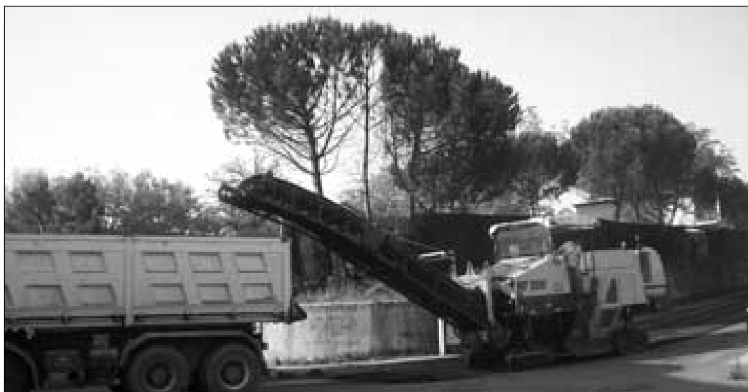
Automezzi al lavoro per asfaltare le strade
