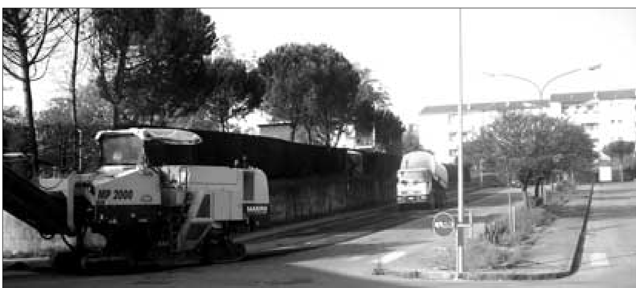
Mezzi in azione per la fresatura e la bitumazione delle strade urbane
