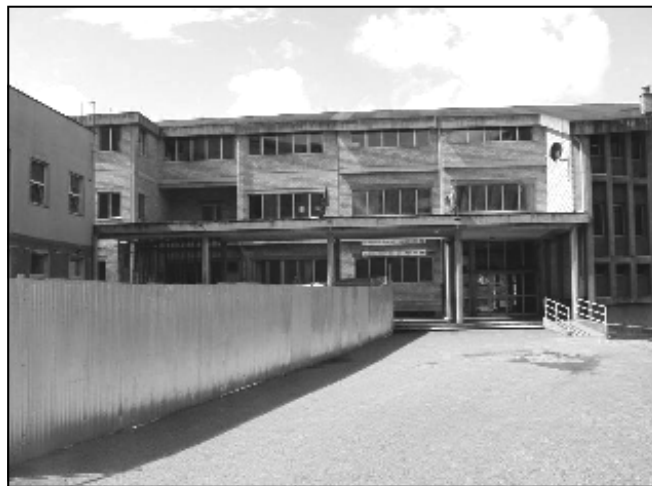
La scuola di via Grimoaldo Re, dove saranno installati i pannelli solari fotovoltaici
