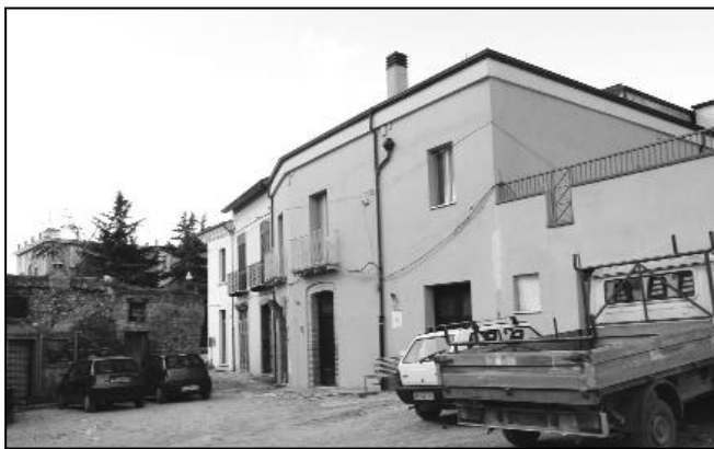
Fabbricati vecchi e nuovi nell'area Bagni
