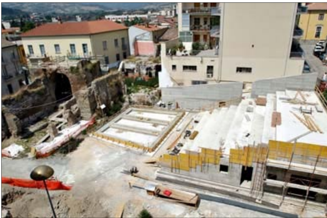
Lavori in corso nell'area dell'Arco del Sacramento
