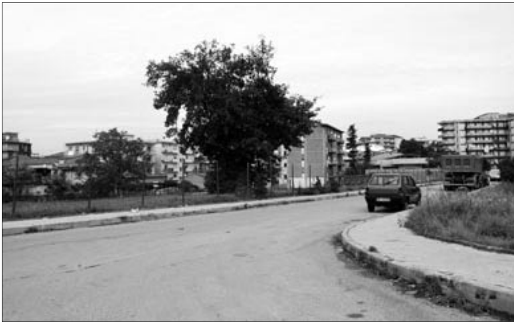
L'area interessata dai lavori di riqualificazione e sistemazione
