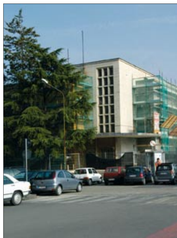
Lavori in corso al plesso "Mazzini"
